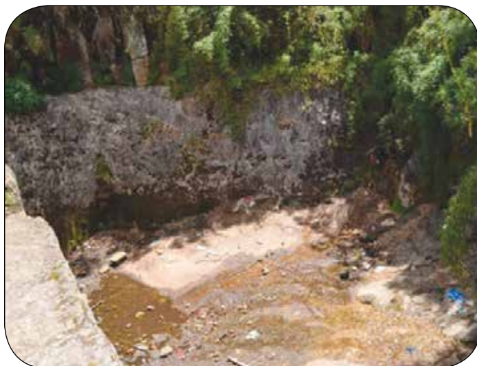
Foto 20. Represa en la quebrada San Cristóbal.
